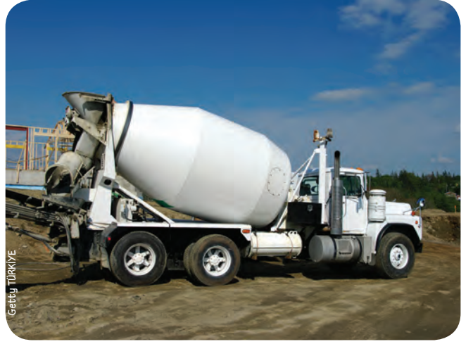
Beton karıştırma kamyonu
