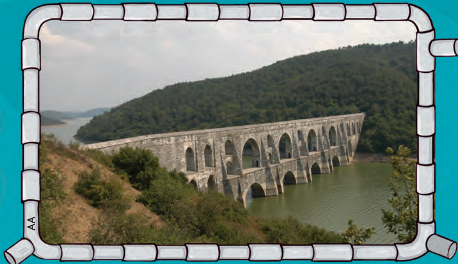
Mağlova Su Kemeri'nin yüksekliği 36 metre, uzunluğu 257 metredir. Çok yüksek olan kemerin devrilmesini önlemek için ayakları tabana doğru piramit şeklinde genişletilmiş.
